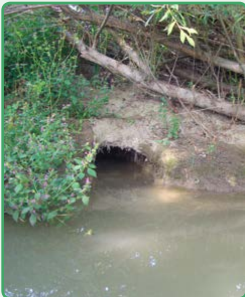
Röhreneingang über Wasser. © Clemens Trixner
